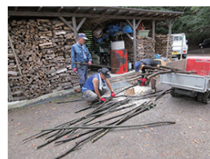
▲杭が安定するように加工します
