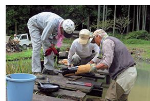
▲腐食防止塗料の塗布
