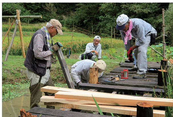
▲支柱の交換は池の中に入っの作業
