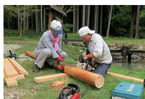
▲現場での支柱製作
