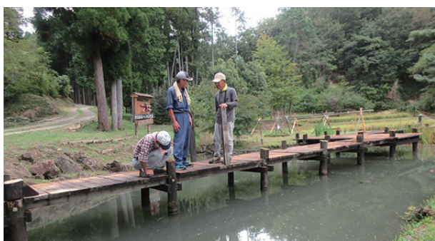
▲手すりが撤去されさっぱりした橋
