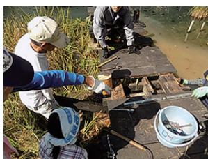
▲橋の保全作業
