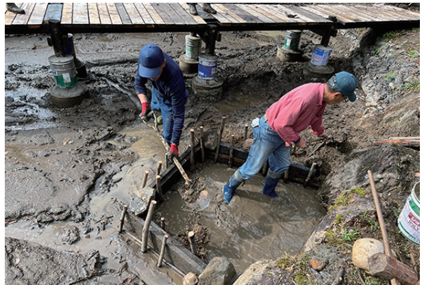
▲水の流入口に設けた堰、名付けて「大見の堰」
