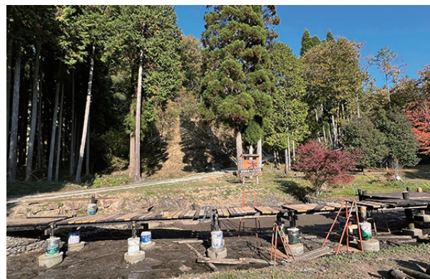
▲10本の支柱交換が完了しました
