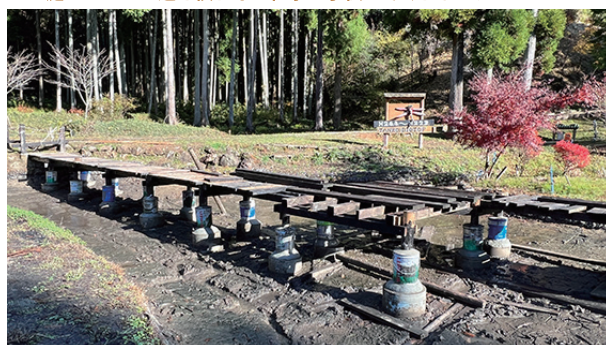
▲完成した新たな支柱です
