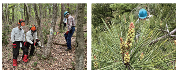
▲危険な枯れ木を伐採
